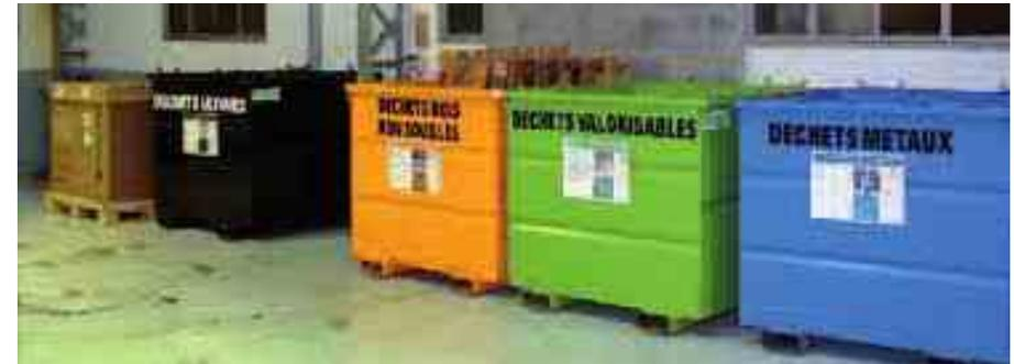
Dispositif de tri des déchets sur le chantier ; le nombre de bennes doit être adapté selon les typologies de déchets rencontrées sur le chantier.
