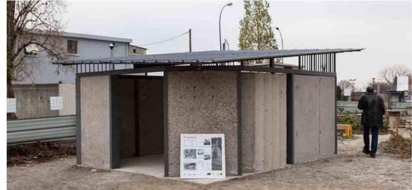
Local ordures ménagères en béton de réemploi – La fabrique du clos, Stains - Bellastock
