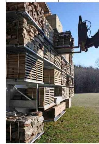
Superposition des matériaux et flexibilité de la structure de stockage en façade pour réduire de l'emprise foncière de stockage - Grange de stockage » - Washington - Gray Organschi architecture
