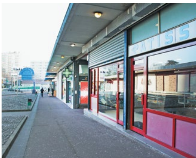
/// Le centre commercial des Presles, avenue de la Marne.
