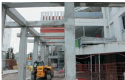
/// Le chantier de la salle des fêtes, en Centre-ville.
