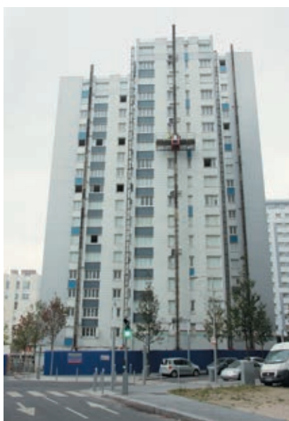
/// Le chantier de démolition de la tour 8L, en Centre-ville.
