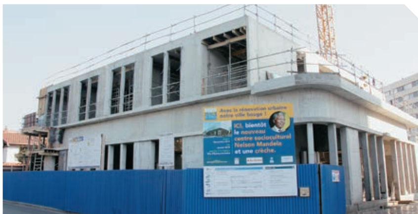
/// Le chantier de l'espace Nelson Mandela, à La Source.
