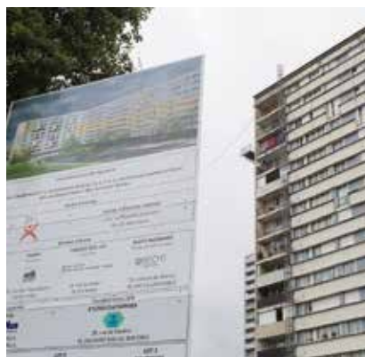
/// Réhabilitation en cours des logements de PCH à La Source.
