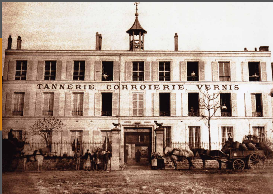
◀ Façade de la tannerie Denant (photographie, collection particulière, 1870).
