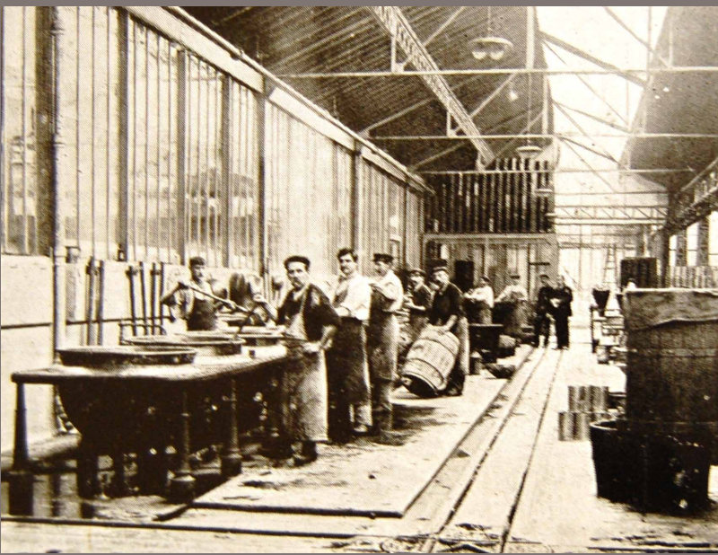
◀ La grande galerie des chaudières pour la cuisson des fruits à la vapeur (photographie extraite du catalogue Bannier, Bibliothèque Forney à Paris).
