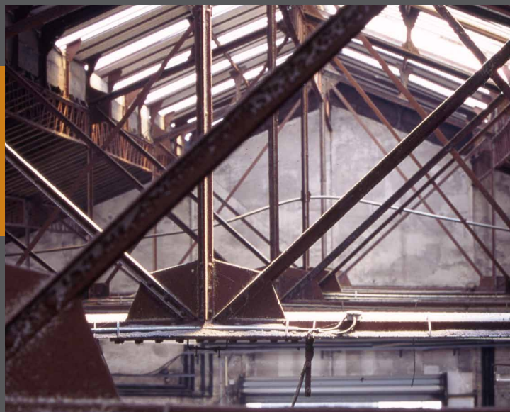
◀ Charpente métallique de l’usine Laforge (photographie, 2000).
