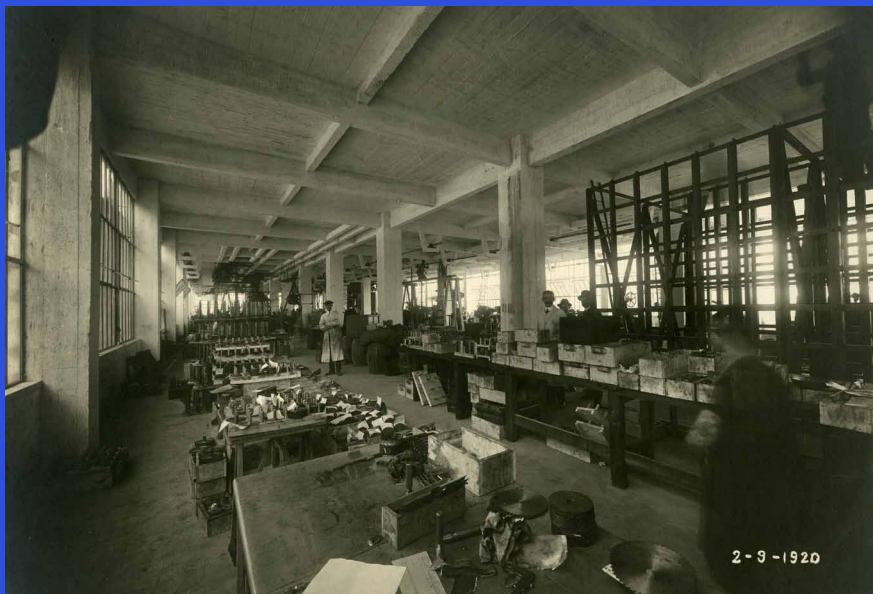
◀ Vue intérieure des usines Curial (photographie Hénault, Cité de l'Architecture et du Patrimoine, 1920).
