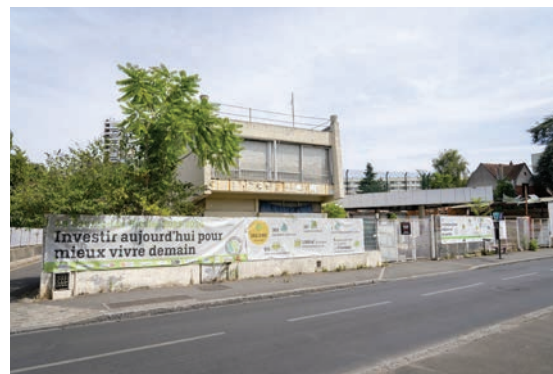
▲ Station-service - Avenue de la Marne
