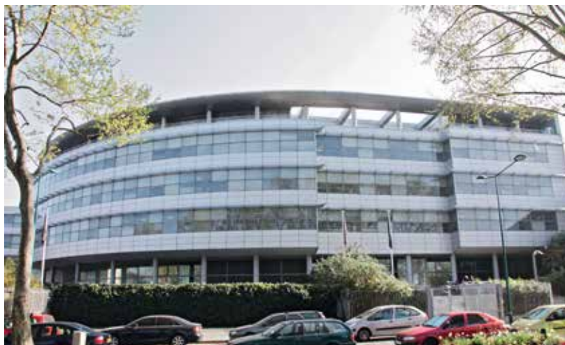
Le siège de l'entreprise Naf Naf, dans le quartier de La Briche-Blumenthal.
