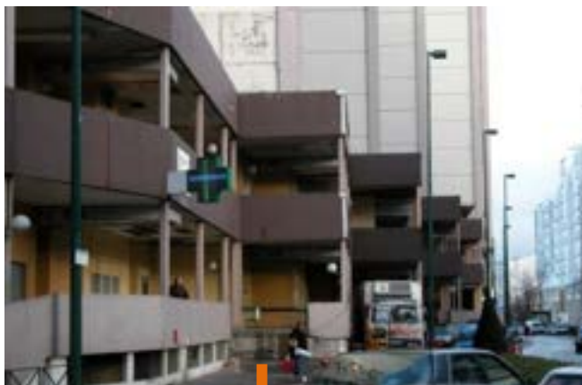
Rue de Paris : abaissement au rez-de-chaussée des halls d'entrée des immeubles
